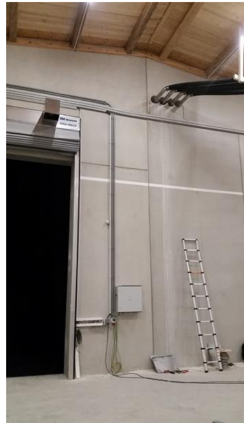
Abbildung 14: zentrale Steuerung im Schaltschrank, Montage an der Hallenwand
