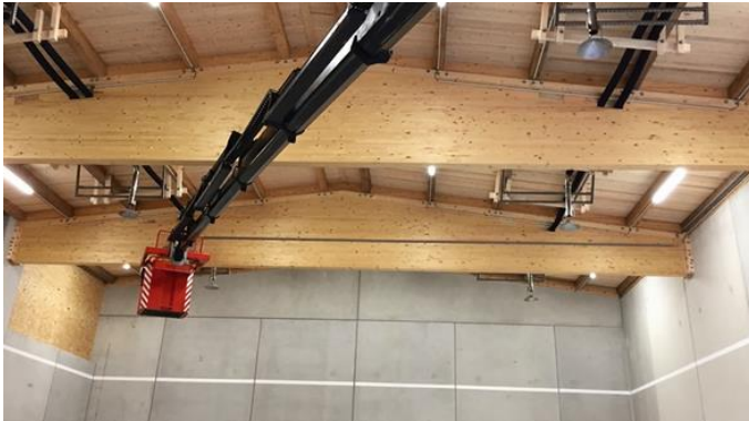
Abbildung 13: Montage der Hallenmessanlage
