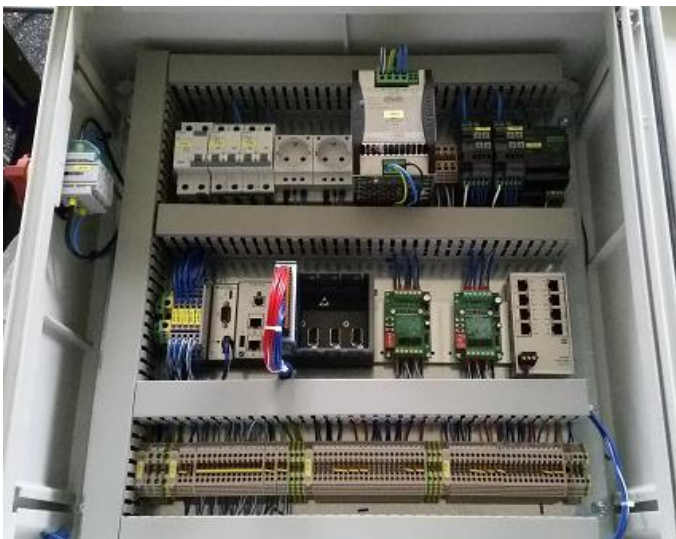
Abbildung 14: zentrale Steuerung im Schaltschrank, Montage an der Hallenwand
