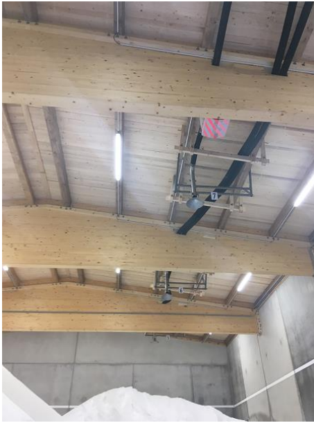
Abbildung 15: Messsystem an der Hallenkonstruktion montiert
