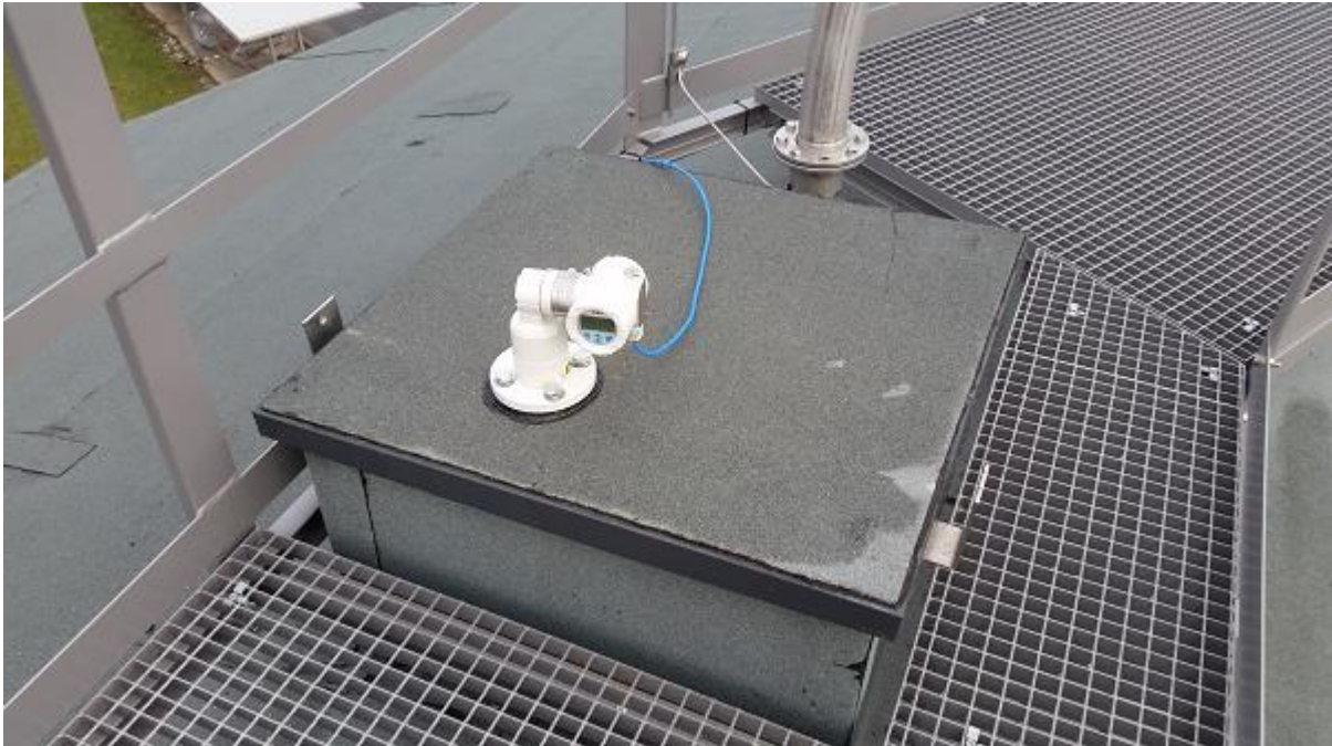
Abbildung 38: Einbau des LLT100 Scanners am Silodach
